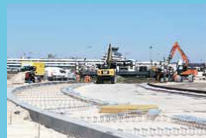
Dezember: Sanierung Rollweg Bravo
